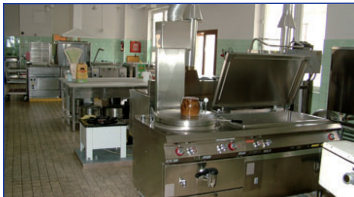
Ve školní jídelně bylo modernizováno technologické zařízení kuchyně
