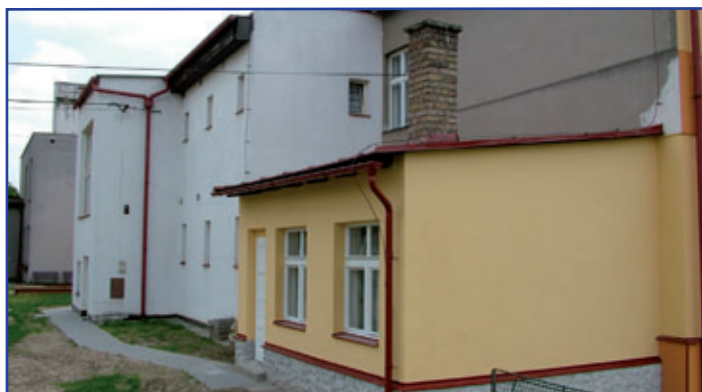
V MŠ Staroholická byla opravena dílna správce a rekonstruován služební byt
