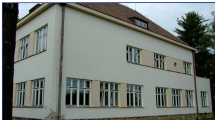
ZŠ Komenského – byla vyměněna okna na budově „opatrovny“ v Růžičkově ulici
