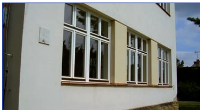
ZŠ Komenského – výměna oken na budově „opatrovny“ v Růžičkově ulici
