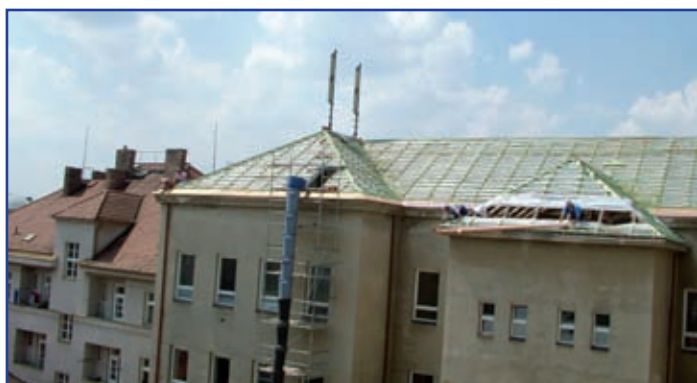
ZŠ Holubova – rekonstrukce střechy
