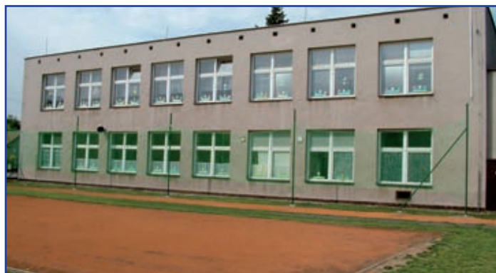
MŠ Staroholická – instalace ochranných sítí na hřišti
