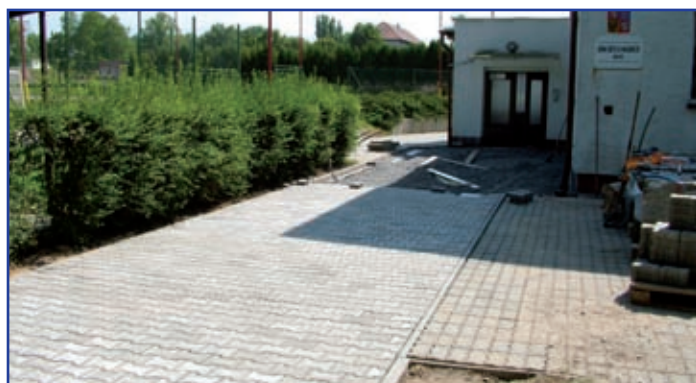
Dům dětí a mládeže – výměna dlažby přístupového chodníku
