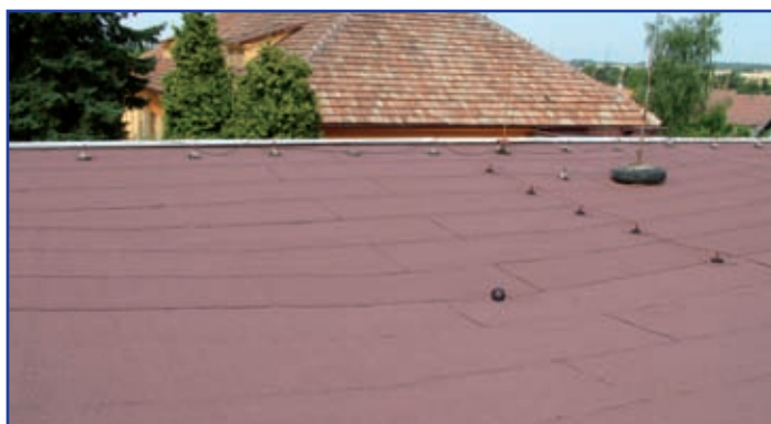
MŠ Staroholická – výměna střešní krytiny nad novější budovou
