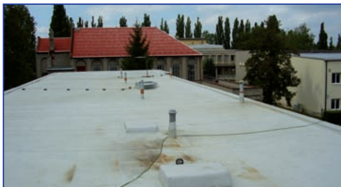
MŠ Holubova - výměna střešní krytiny
