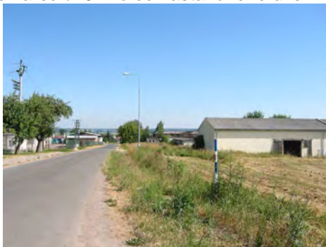
průjezdny úsek silnice III/32253
