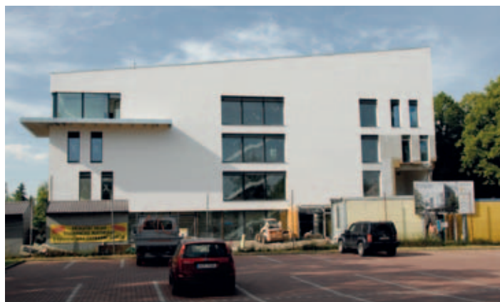
10. červen 2014 – Škola krátce před dokončením, upravuje se již i okolí.
