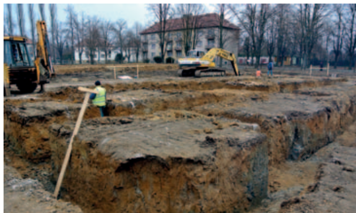
9. duben 2013 – Základy vykopány.
