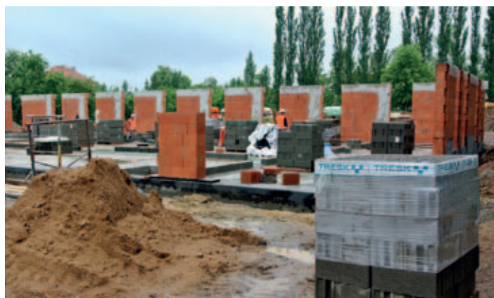
10. červen 2013 – Zedníci se činí a stavba roste ze země.
