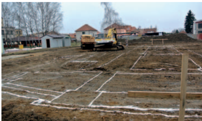
5. duben 2013 – Staveniště předáno a může se kopat.
