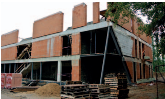
4. září 2013 – Budova už vyrostla a pracuje se na 2. patře.
