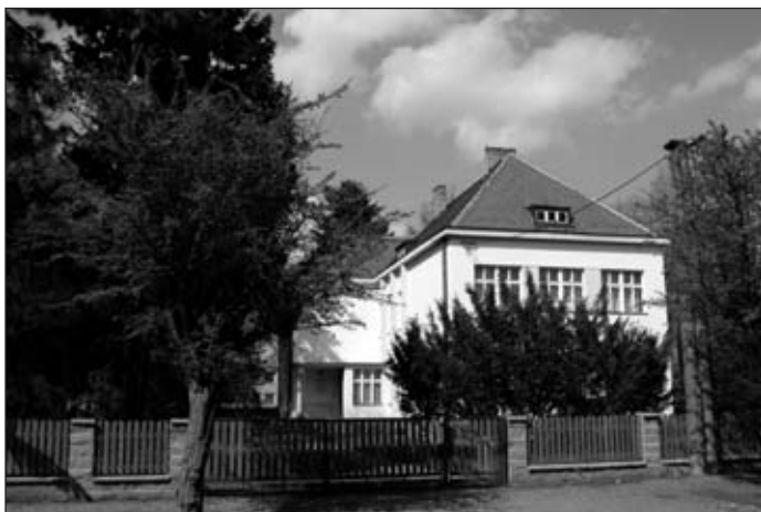
Venkovní i vnitřní úpravy školní budovy v Růžičkově ulici
