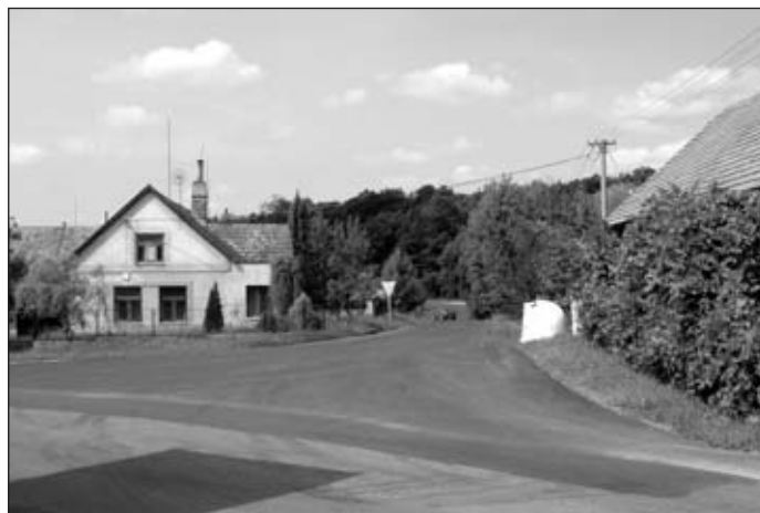
Rekonstrukce komunikace Holice – Podleší
