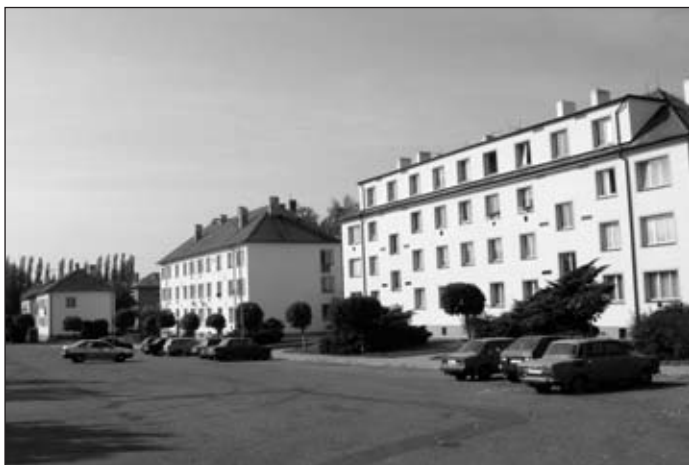
Nové fasády na městských domech v Holubově ulici
