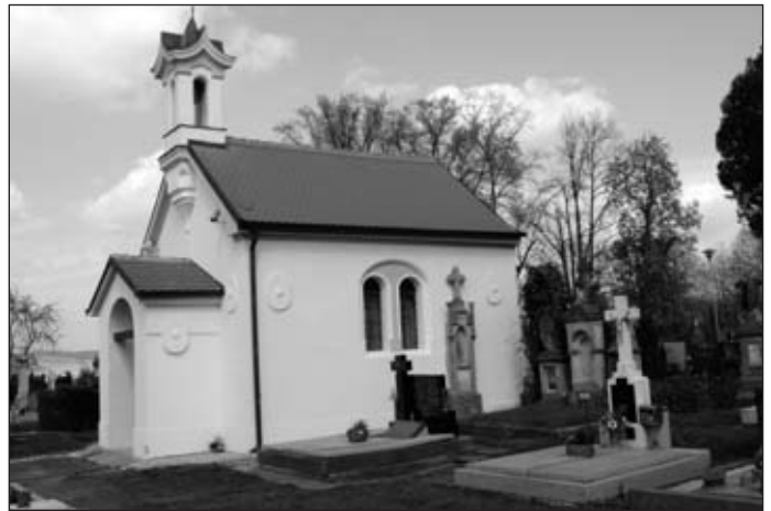
Oprava kaple na hřbitově
