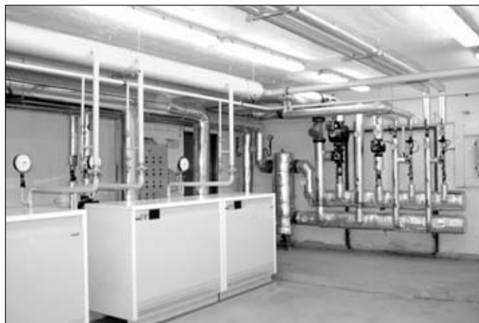
Rekonstrukce kotelny v Základní škole Holubova
