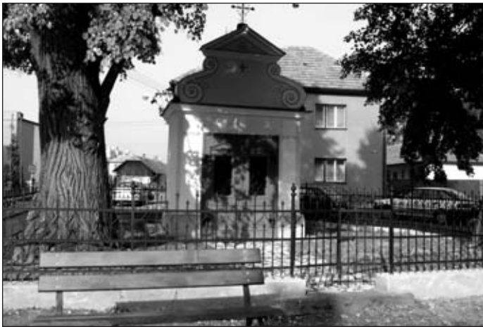
Oprava kapličky sv. Jana u kostela
