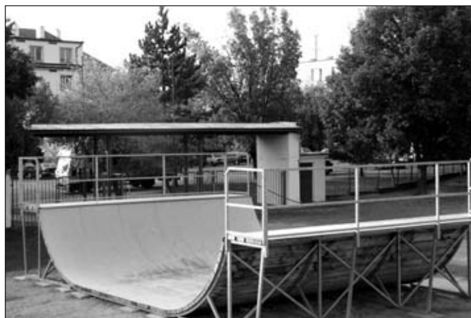
Vybudování U – rampy v areálu městského stadionu
