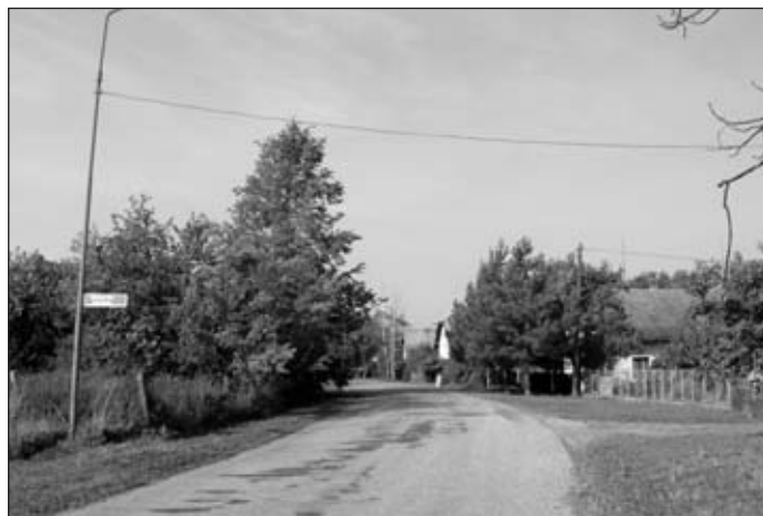
Rekonstrukce komunikace v místní části Roveňsko
