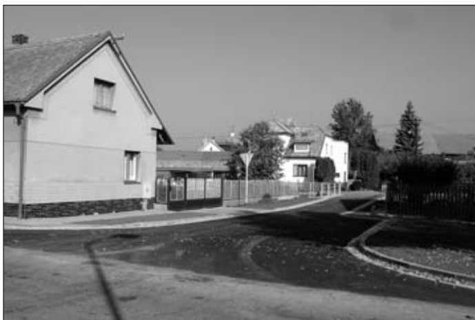
Rekonstrukce komunikace a mostku v místní části Podhráz
