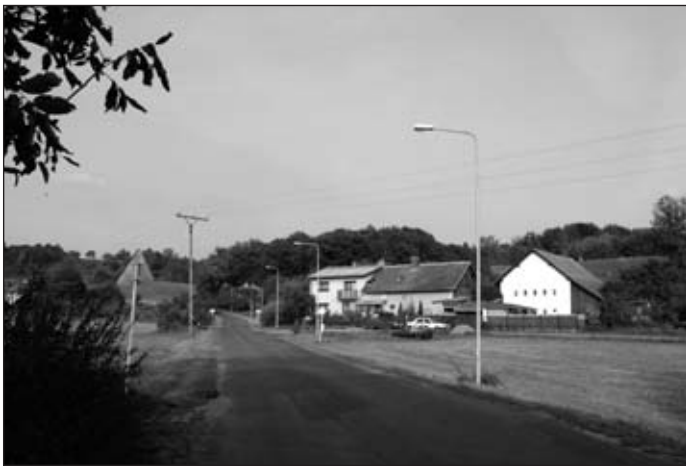
Výměna veřejného osvětlení v místní části Kamenec
