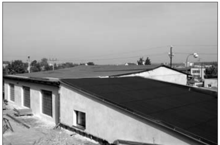
Nový sklad v areálu Technických služeb (Vysokomyštská ulice)
