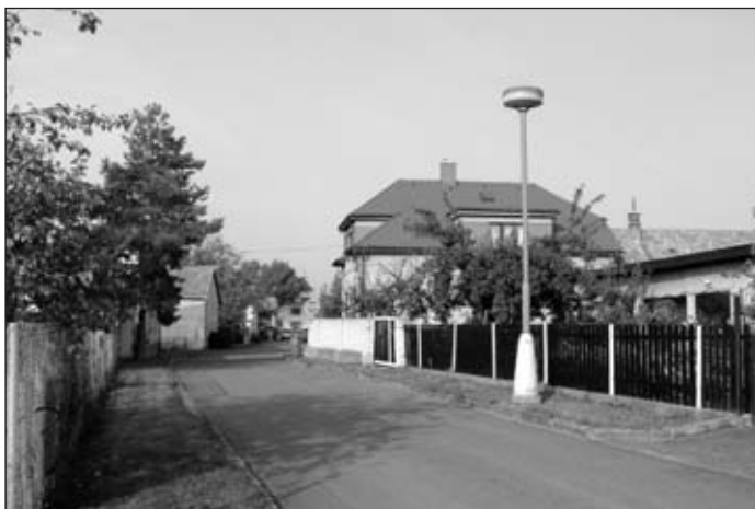
Celoplošná oprava Vrchlického ulice (Staré Holice)
