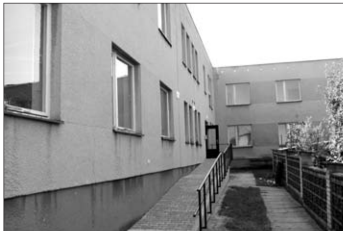
Rekonstrukce domu s pečovatelskou službou v ulici U Kapličky včetně vybudování 7 garsoniér pro sociální účely
