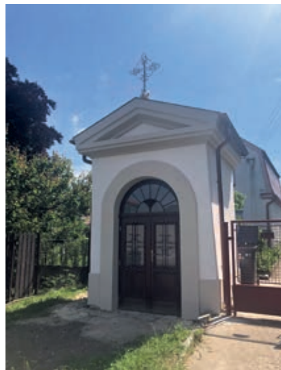
Zrekonstruovaná kaple sv. Josefa ve Smetanově ulici
