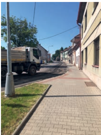
Oprava povrchu vozovky také ve Smetanově ulici
