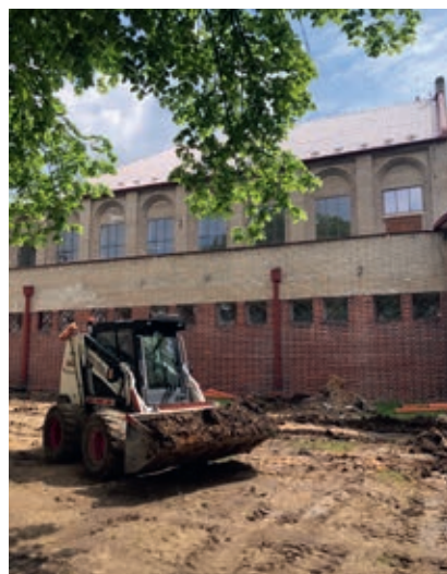
Začala druhá etapa revitalizace Sokolského parku, při které dojde mimo jiné k vybudování nádrže na dešťovou vodu
