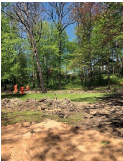
Instalace nového osvětlení a realizace mlatových cest v Městském parku
