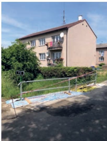
Nové zábradlí přes Ředický potok v ulici Na Balkáně
