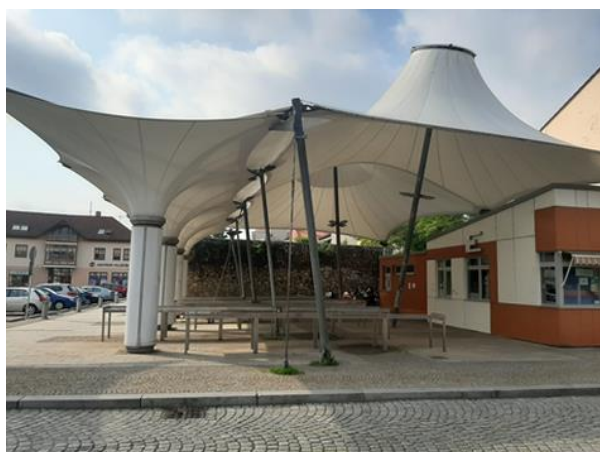
Zastínění tržiště v Novém Jičíně bylo realizováno pomocí tahové textilní membrány na nosné ocelové konstrukci (foto CI2).
