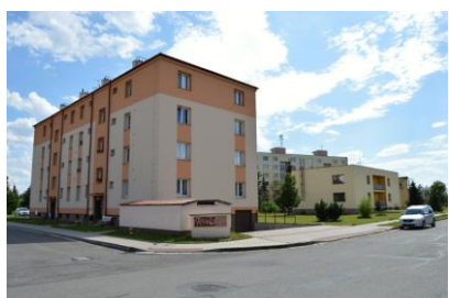
Bytový dům Na Mušce / Neptalimova nabízí možnost instalace FV panelů na JZ orientované střeše. Dům je v majetku města.
