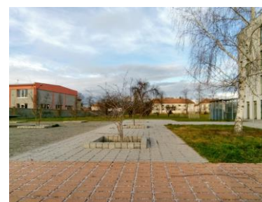
Dlažba za budovou ZUŠ se širokou spárou (cca 30 mm) může obsahovat přes 25 % zeleně a zvyšuje vsakování. Je doplněna propustným povrchem.
