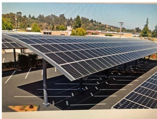
Koncepce „solárního stromu“ poskytujícího stín zaparkovaným automobilům a současně vyrábějícího elektřinu se uplatní na veřejných parkovištích, pro řidiče elektromobilů (foto ASB).
