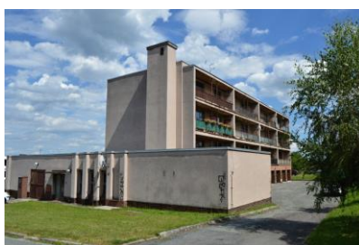
Bytové domy v Družstevní ulici mají potenciál pro celkovou obnovu. Domy jsou v soukromém vlastnictví
