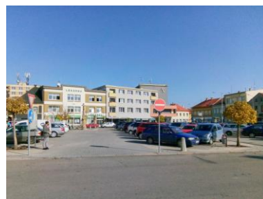
Betonová „zámková“ dlažba a asfalt na náměstí T.G.M.
