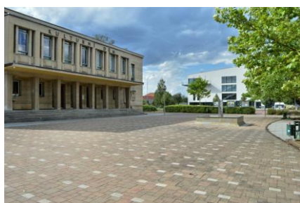
Probarvená skladebná dlažba na piazzetě před kulturním domem typologicky odpovídá charakteru místa. K úvaze je větší spára a volba kvalitnějšího materiálu.
