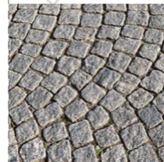
žulová kostka skládaná do vlašťovky velikost kostky 80 - 100 mm silnice ve zklidněném dopravním režimu
