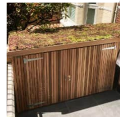
přístřešek se zelenou střechou a dřevěnými plaňkovými fasádami přístřešek pro popelnice tříděného odpadu
