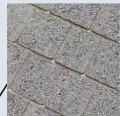
skládaná betonová mozaika do řádku velikost: 100 x 100 mm výška dlažby: 80 mm, pro vstupy 60 mm ulice U Kapličky + vstupy k rodinným domům
