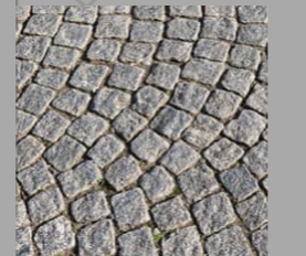
žulová kostka skládaná do vjaštovky velikost kostky 80 - 100 mm silnice ve zklidněném dopravním režimu
