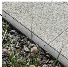
betonový zahradní obrubník vjezdy a vstupy s betonovou dlažbou
