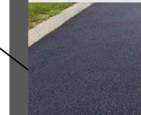
stávající asfaltový povrch komunikace silnice v nezklidněném dopravním režimu
