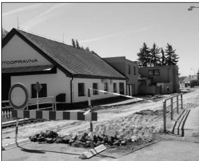
Oprava Husovy ulice
